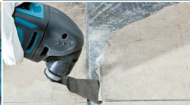
Удаление напольной плитки
