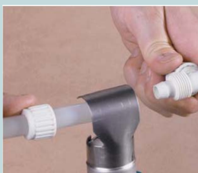
Монтаж пластиковых труб
