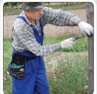
Использование сумки при строительстве забора в саду.
