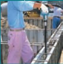
Для качественной трамбовки бетонных фундаментов и стен. Повышает прочность бетонных конструкций.
