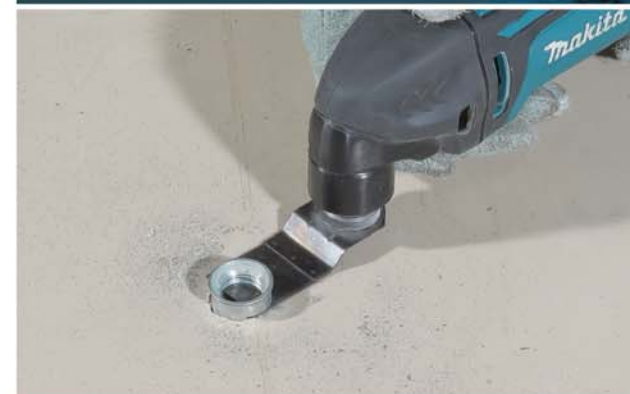
Резка металлических труб заподлицо
