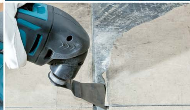
Удаление напольной плитки
