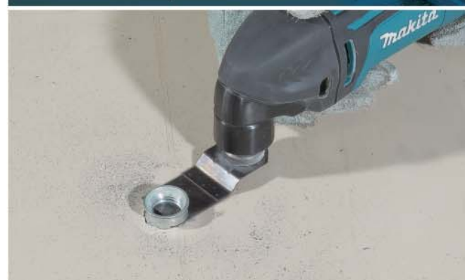
Резка металлических труб заподлицо
