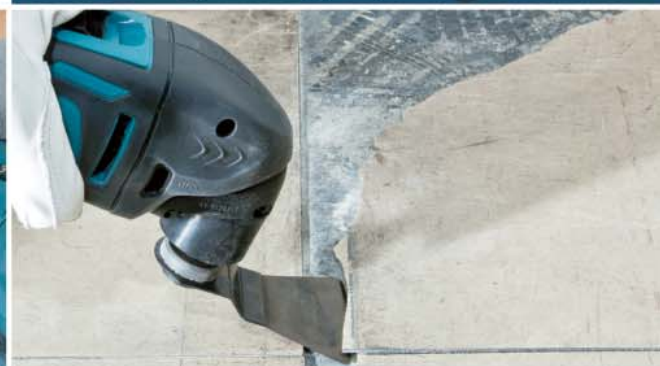
Удаление напольной плитки
