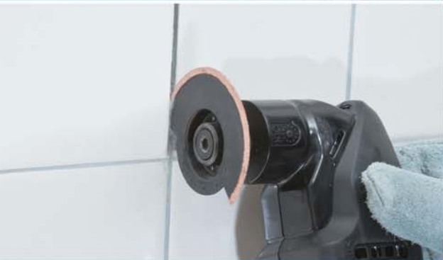
Очистка швов между плиткой
