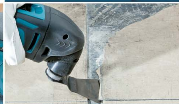
Удаление напольной плитки
