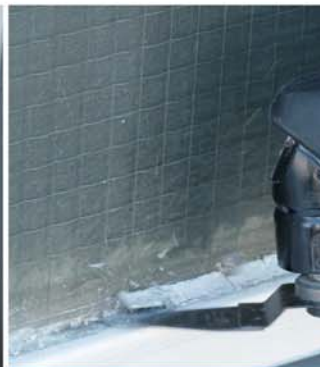
Удаление оконной замазки
