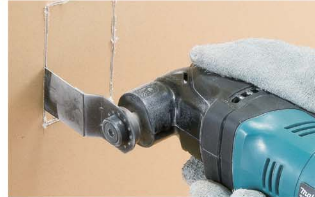
Резка гипсокартона
